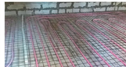
Опалення будинку з пінобетонних блоків, монтаж системи
