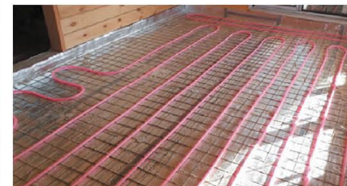
Опалення будинку з бруса, монтаж системи
